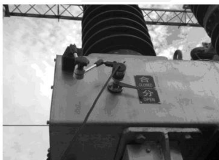
35KV SF6 开关传感器安装
